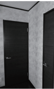
開け閉めしにくくなったドアも、枠からリフォームすればスムーズに
