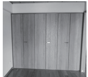
幅一間半の押入れがクローゼットに
