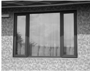
改装後の窓。断熱性に優れ、屋内に差し込む紫外線・赤外線を減らす。
